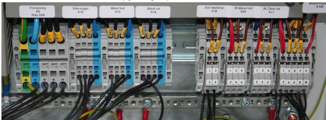
В нижней части электрораспределительного устройства можно подключить дополнительный аварийный выключатель, а также арматуру датчика для управления движением ленты внутрь и наружу
