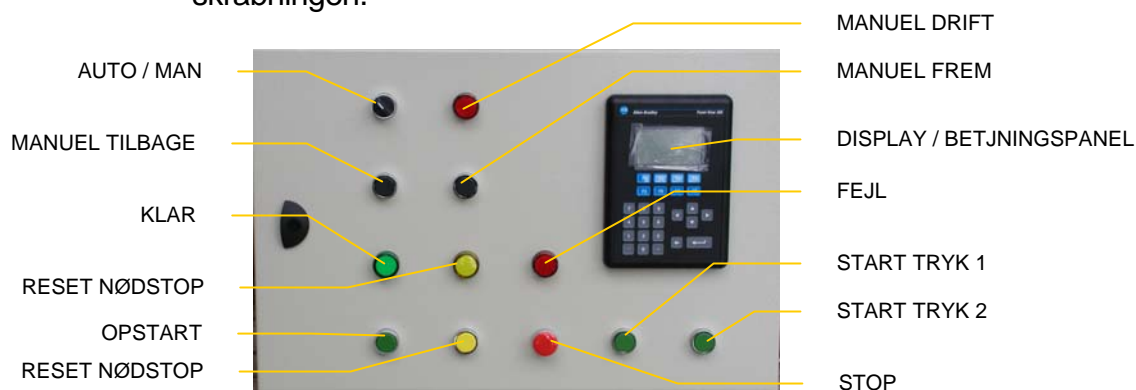
Figur 2. Skab 2. ”PLC Skab”
